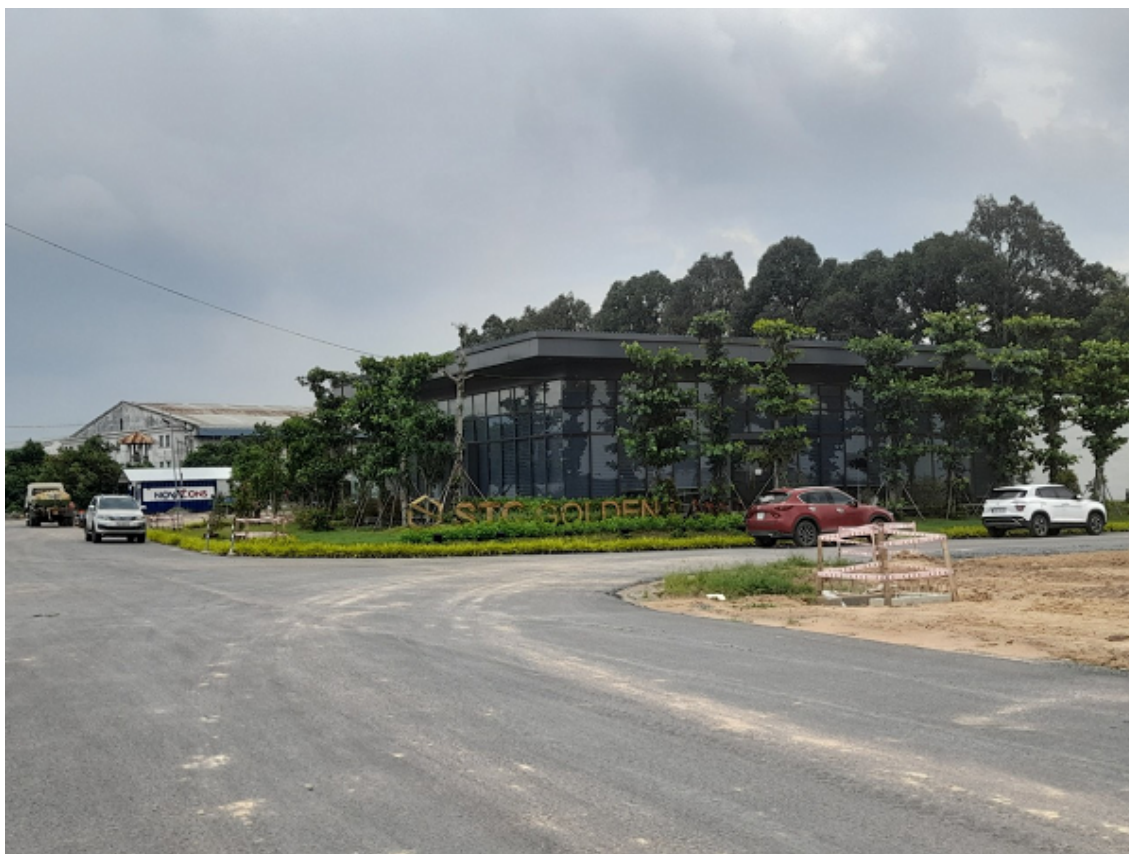
Hiện trạng thi công tại STC Long Thành
