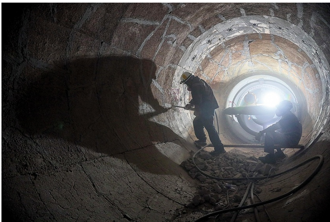
Các kỹ sư đang bảo dưỡng đường ống công nghệ tại Cụm phân xưởng RFCC trong đợt bảo dưỡng tổng thể lần 5 Nhà máy Lọc dầu Dung Quất
