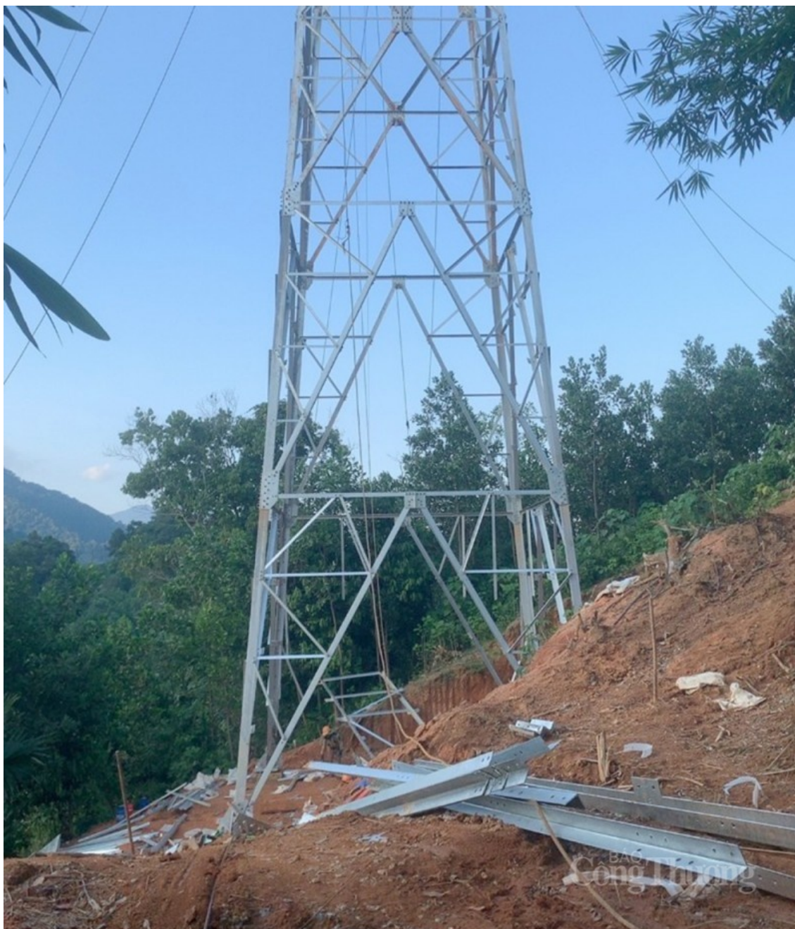
Thi công đường dây 220kV Nậm Sum – Nông Cống gặp nhiều khó khăn do vướng mắc bồi thường, giải phóng mặt bằng. (Ảnh Xuân Tiến).
