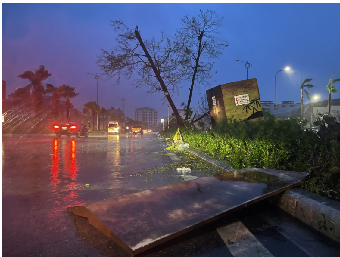
Bốt điện bị đổ ảnh hưởng đến việc cung cấp điện cho người dân thành phố
