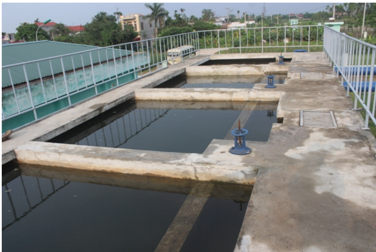
Nhà máy nước sạch xã Đồng Du, huyện Bình Lục
