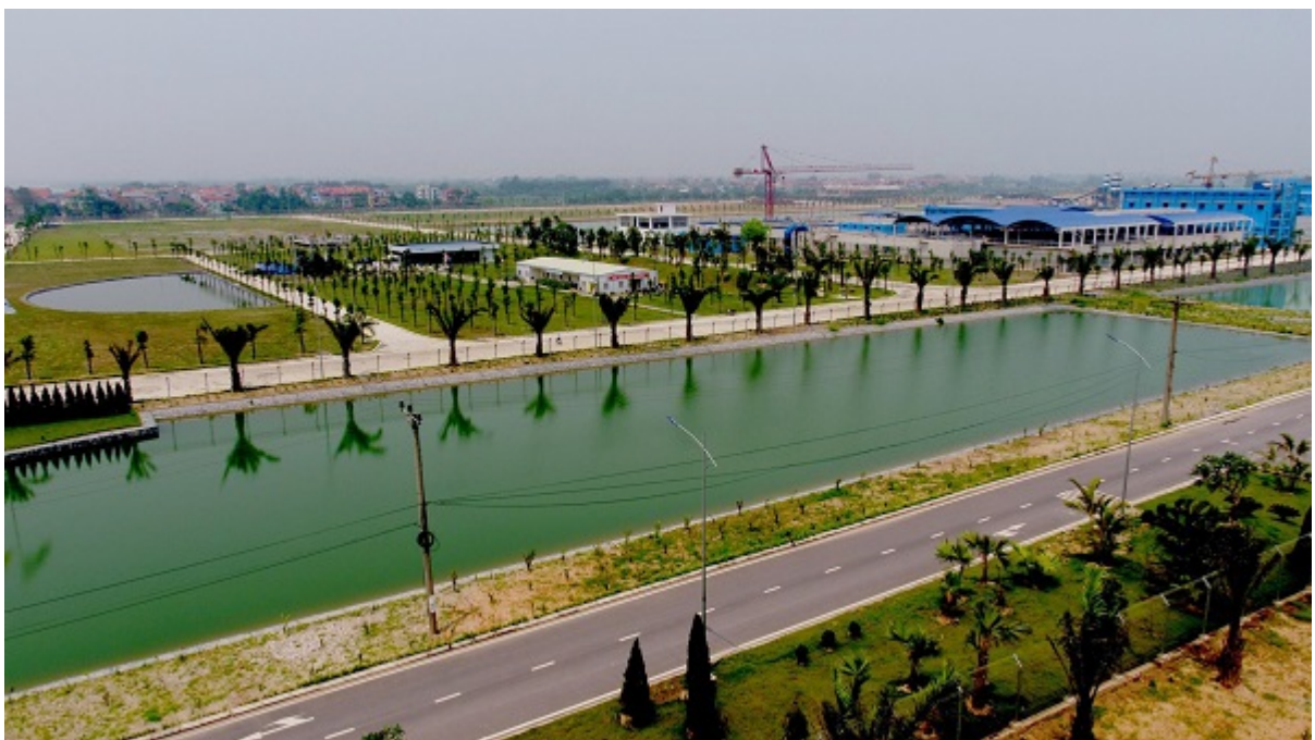
Nhà máy nước mặt sông Đuống
