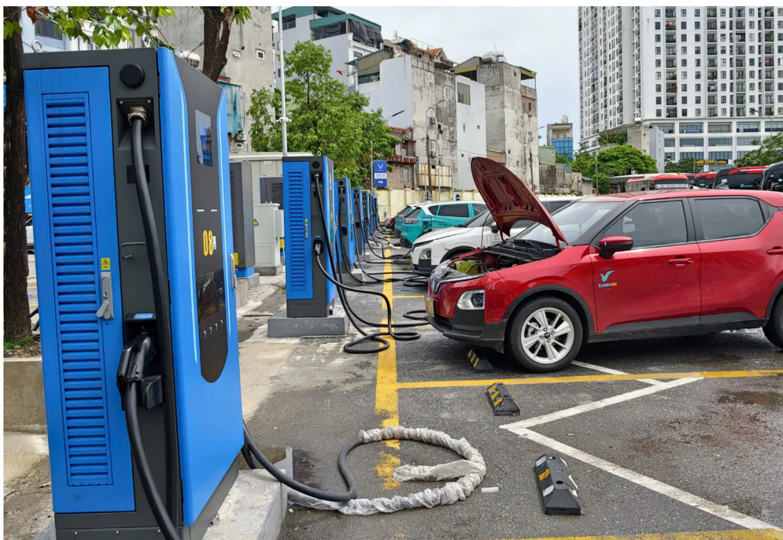
Tại bến xe Gia Lâm, hơn 30 hạm sạc xe điện đang được triển khai lắp đặt. Ảnh: Phạm Công
