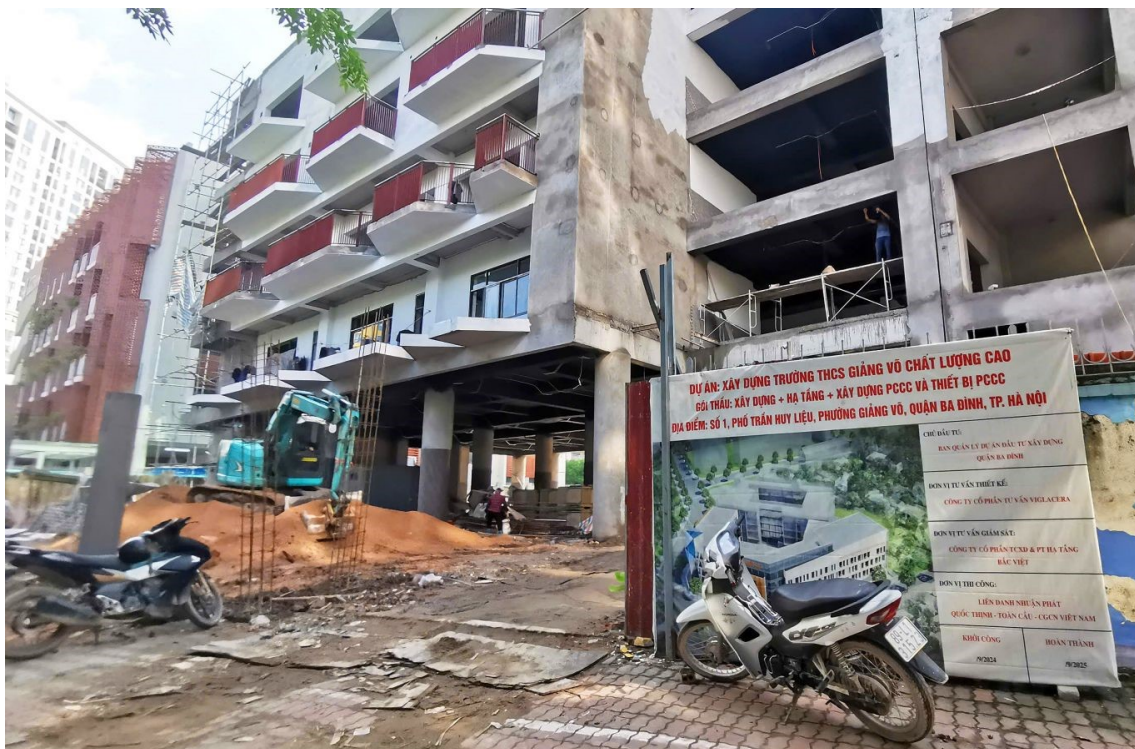
Công trình xây mới Trường THCS Giảng Võ 2 (phường Giảng Võ) đang khẩn trương hoàn thiện các hạng mục cuối cùng, để kịp đưa vào sử dụng trong năm học mới 2025 - 2026. Ảnh: Tuấn Ngọc
