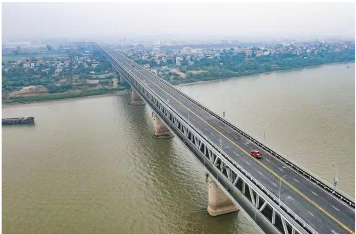
Hà Nội chuẩn bị sửa chữa hai bên cầu Thăng Long đảm bảo ATGT
