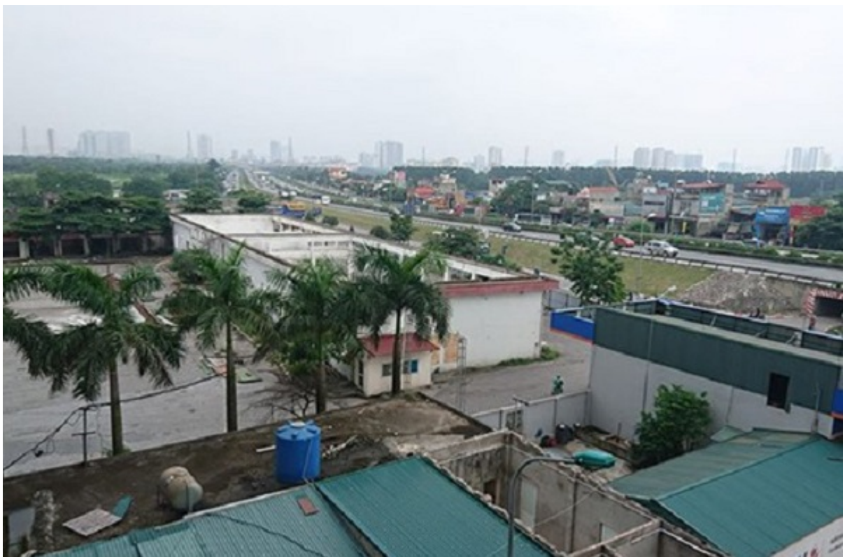
Lô đất đang được giải tỏa để xây dựng bến xe Yên Sở
