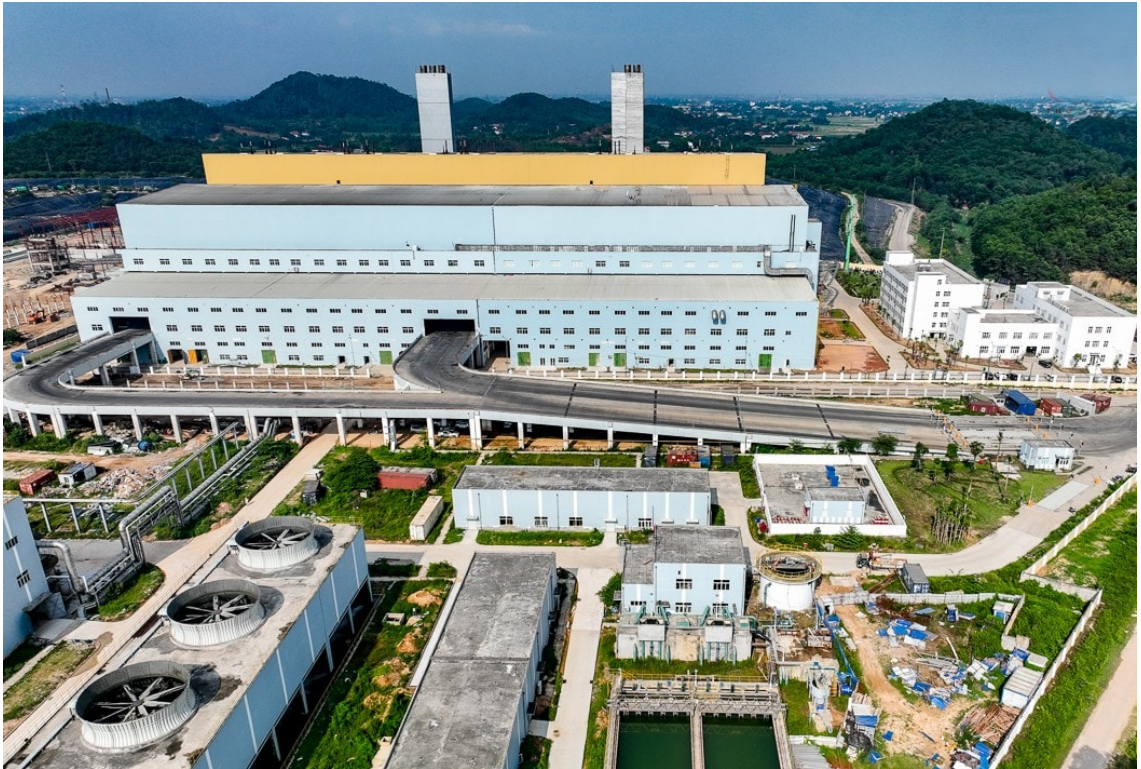
Nhà máy điện rác Sóc Sơn có công suất tiếp nhận 5.000 tấn/ngày đêm, phát điện 90 MW/h. Ảnh: Hoàng Sơn
