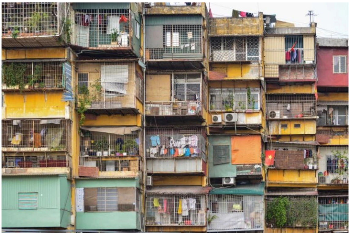
Khu tập thể 3 tầng trên đường Lê Hồng Phong, phường Hà Đông.
