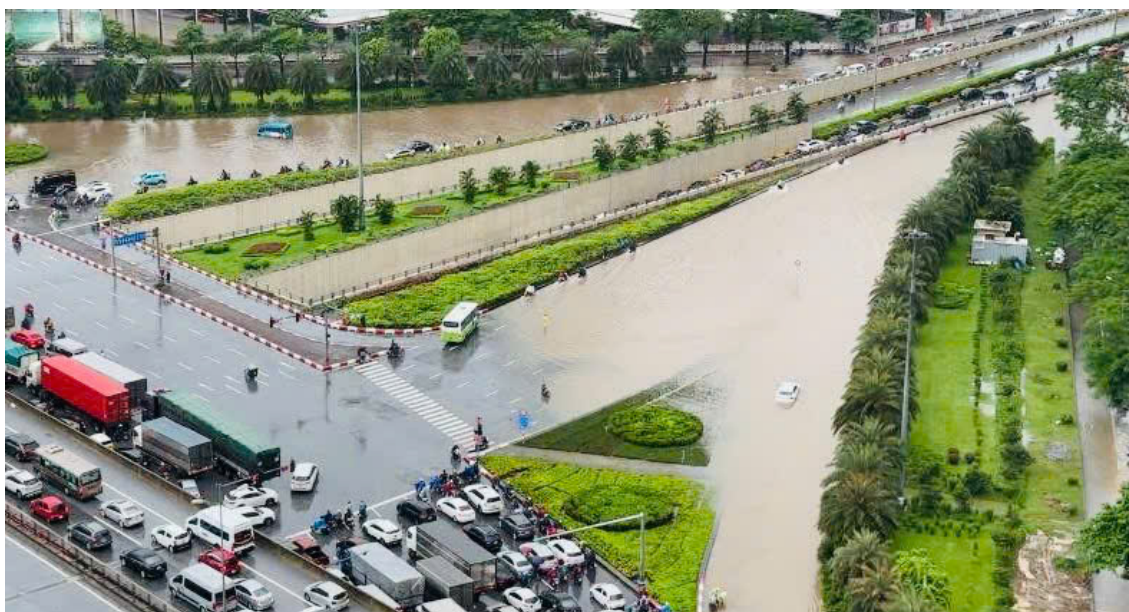
Nút giao Phạm Hùng - Trần Duy Hưng - Vành đai 3 trên cao ngập trong biển nước sáng 26/8
