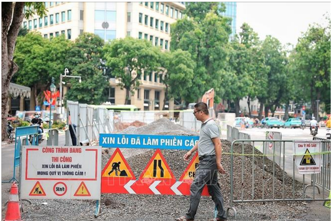
Người dân lưu thông qua khu vực công trường đang triển khai dự án xây dựng hệ thống thoát nước chống ngập khu vực nội đô Hà Nội. Ảnh minh họa: Phạm Tuấn Anh/TTXVN
