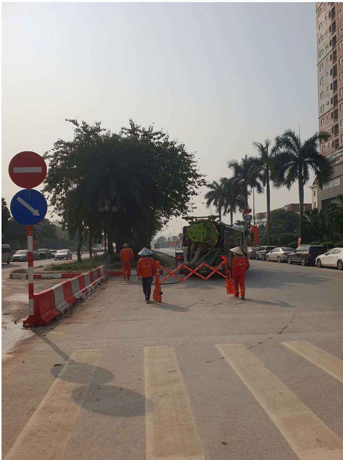
Lực lượng duy tu hạ tầng giao thông tổ chức vệ sinh mặt đường, làm sạch dải phân cách và hệ thống biển báo.
