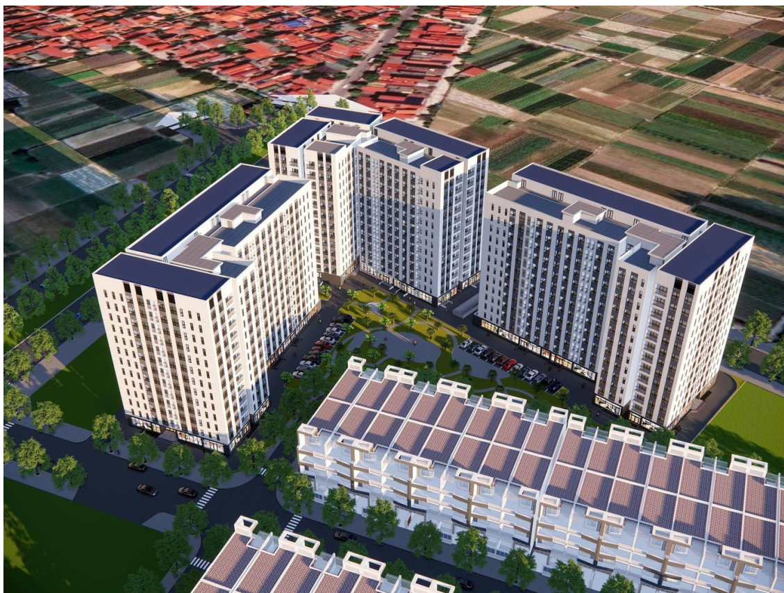
Ô đất CT thuộc dự án Khu nhà ở Minh Đức
