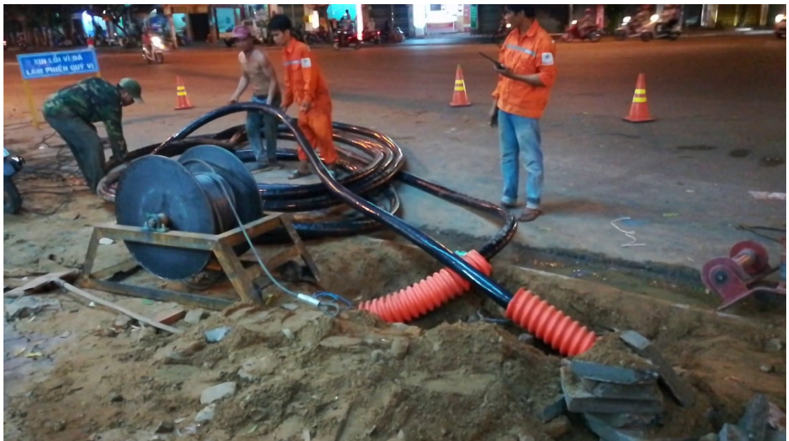
Công nhân kỹ thuật hạ cáp và bó gọn dây trên cao trong đợt chỉnh trang cuối năm.
