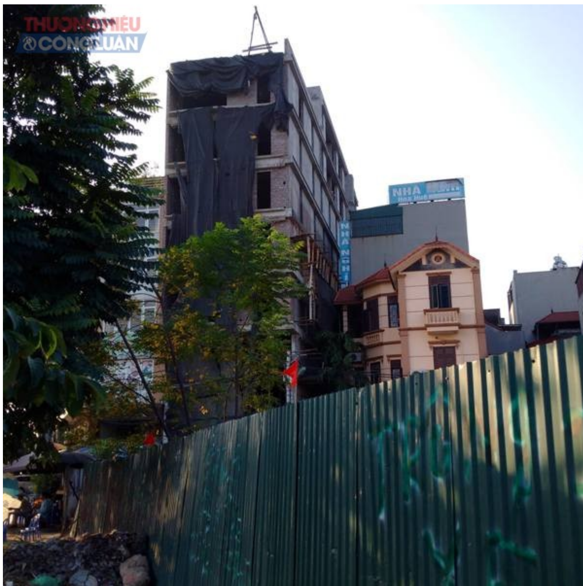
Công trình số 3, ngõ 2 Đại Lộ Thăng Long
