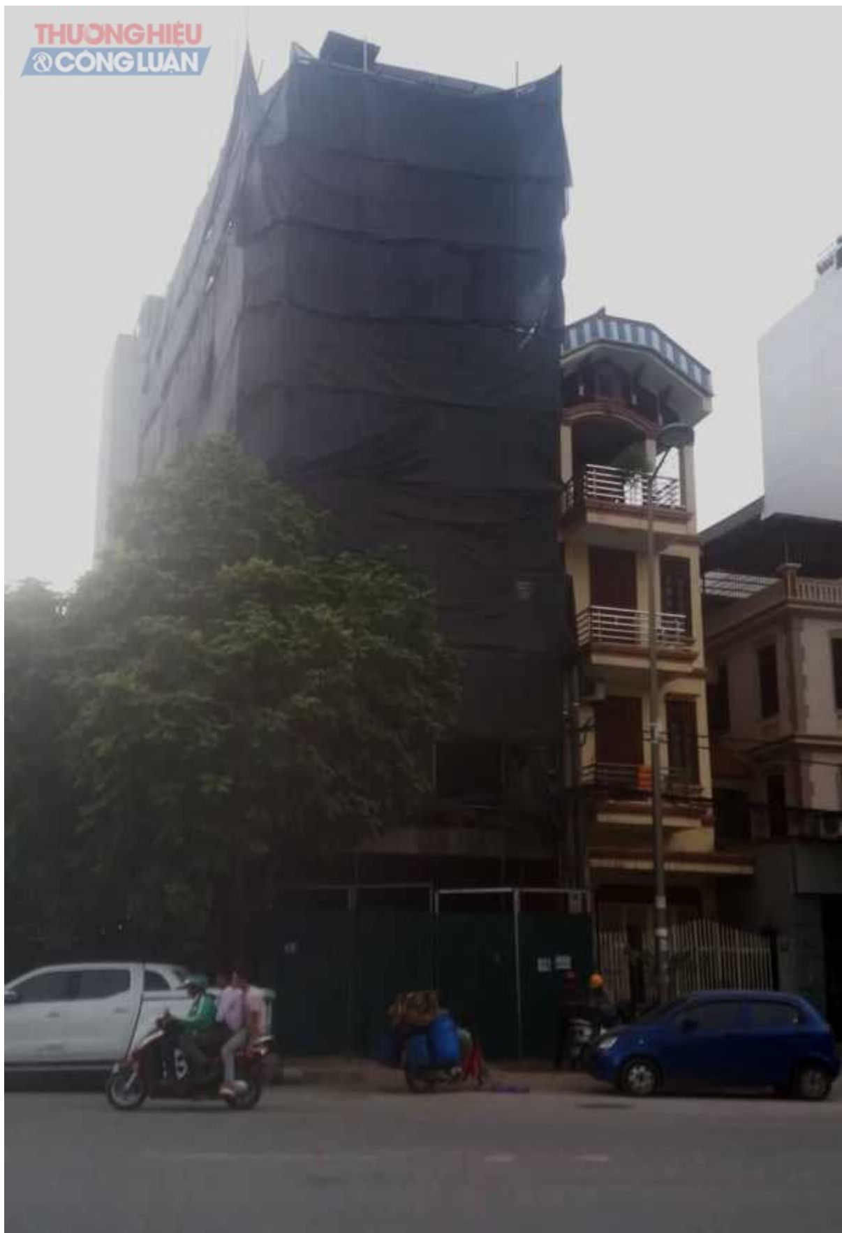
Công trình số 78 Miếu Đàm
