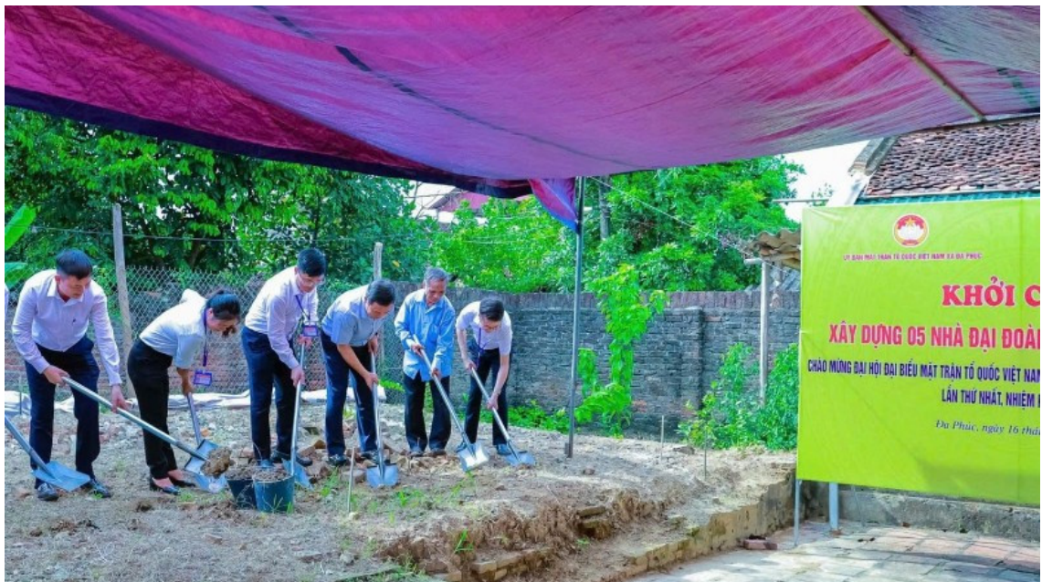
Khởi công xây dựng nhà Đại đoàn kết tại xã Đa Phúc (Hà Nội).
