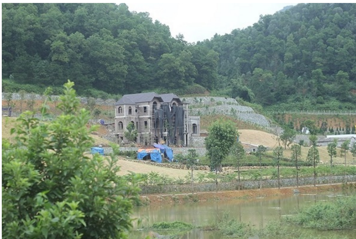
Công trình xây dựng ngay tại khu vực hồ Đồng Đò (Ảnh: T.Vương)
