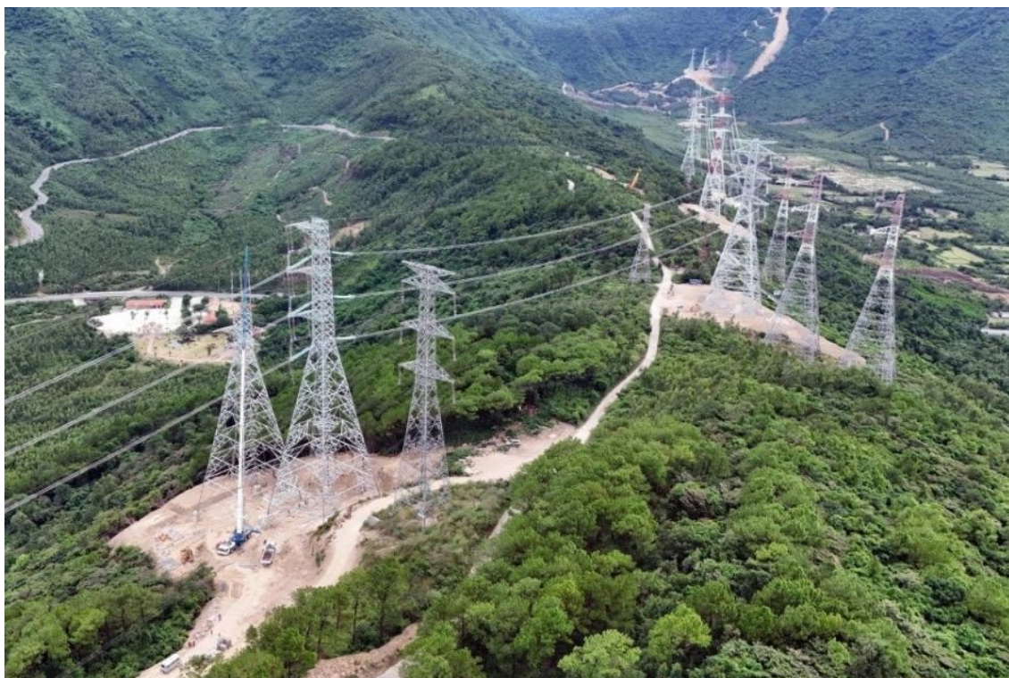
Dự án đường dây 500 kV mạch 3 đoạn qua Hà Tĩnh
