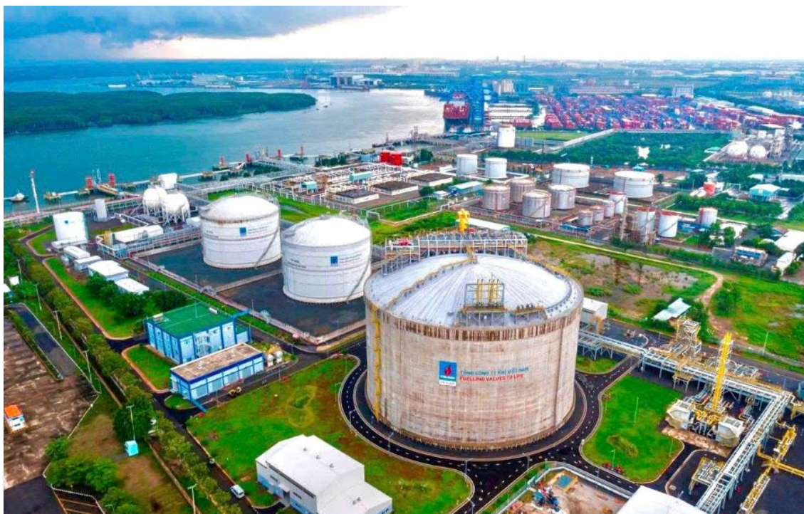
Dự án Kho LNG Bắc Trung Bộ do Tổng Công ty khí Việt Nam - Công ty cổ phần (PV GAS) làm chủ đầu tư.
