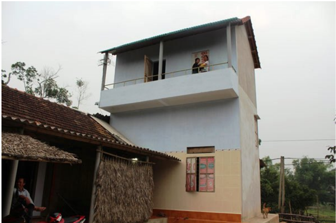
Một công trình nhà tránh lũ tại huyện Hương Khê.
