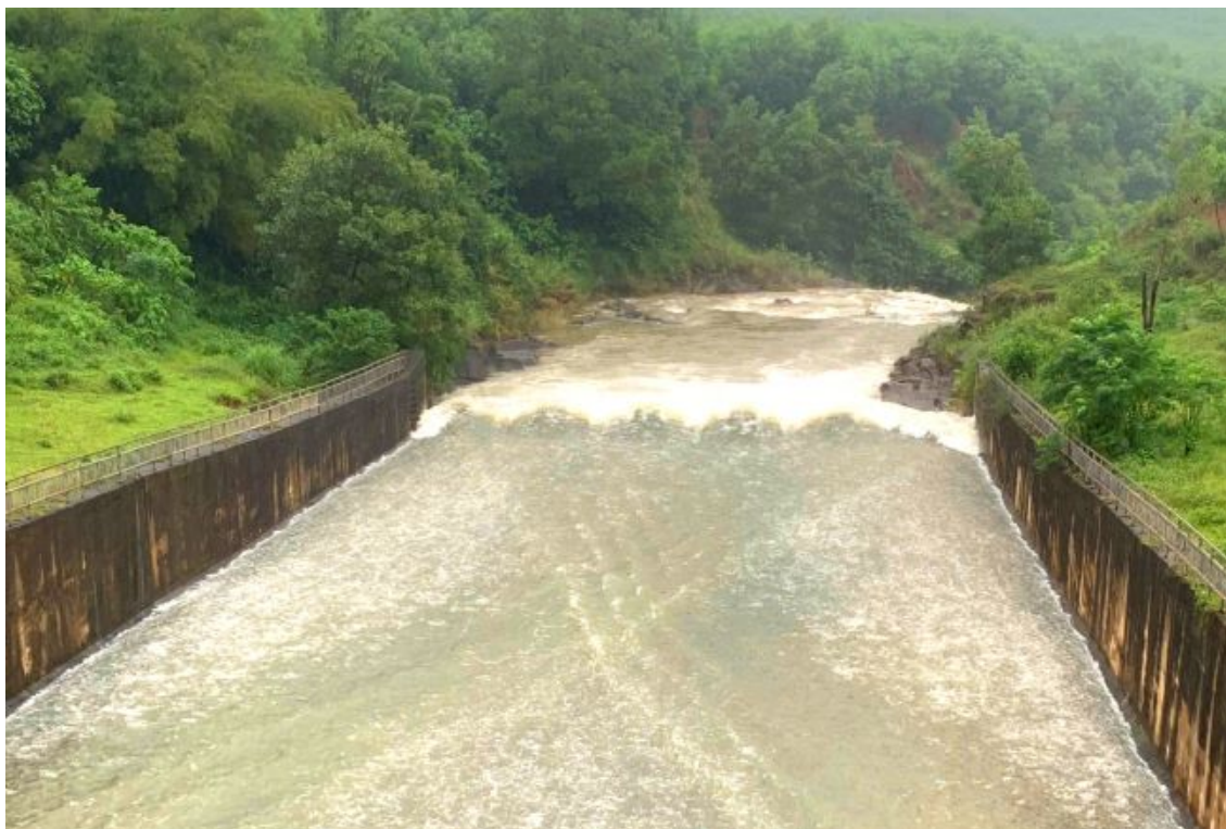
Hồ chứa nước Thượng Sông Trí xả tràn ứng phó mưa lớn.
