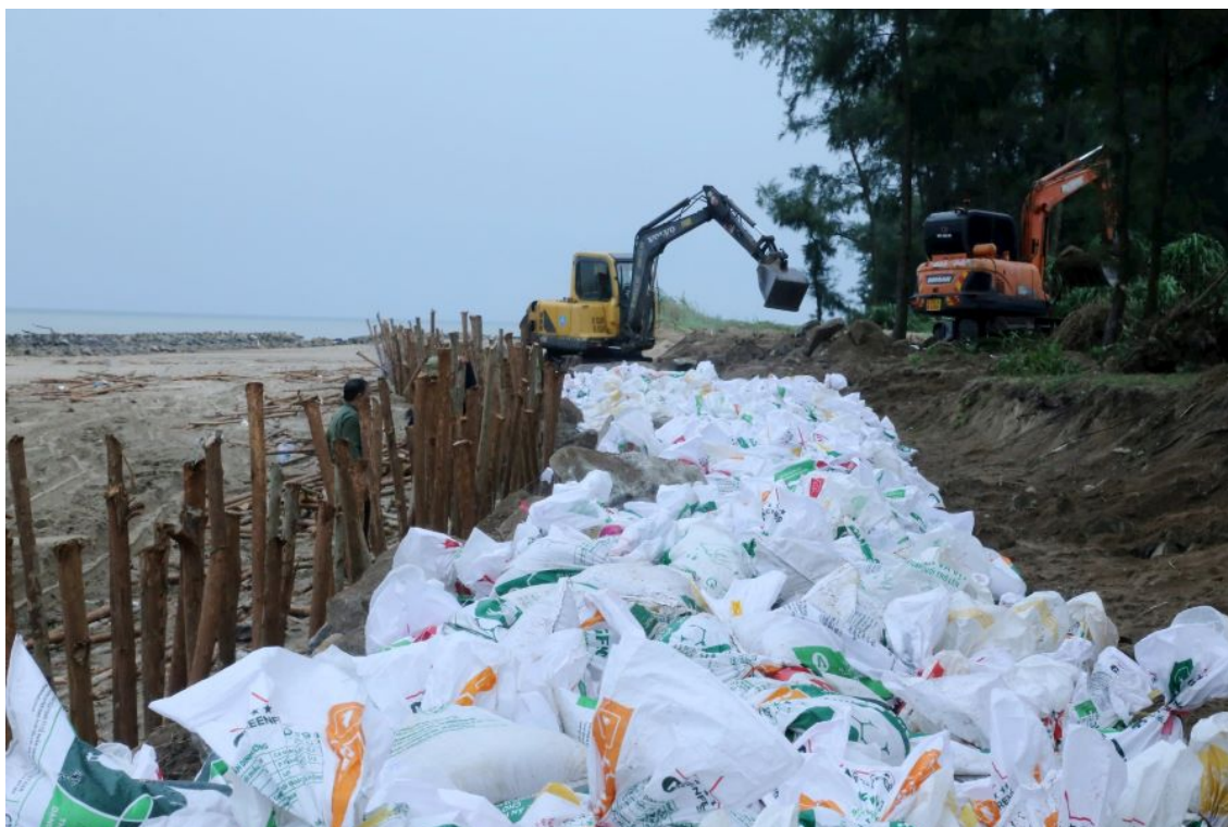
Dùng cọc cùng với đá hộc và bao cát để làm bờ kè tạm đối phó với bão số 5.
