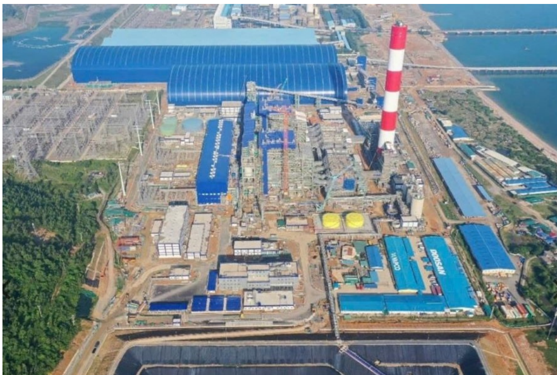
Toàn cảnh Nhà máy Nhiệt điện Vũng Áng II
