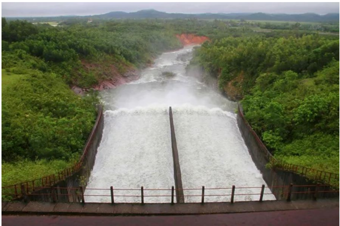
Hồ Kẻ Gỗ xả tràn, hạ thấp mực nước ứng phó với dự báo mưa lớn do bão số 10 gây ra.
