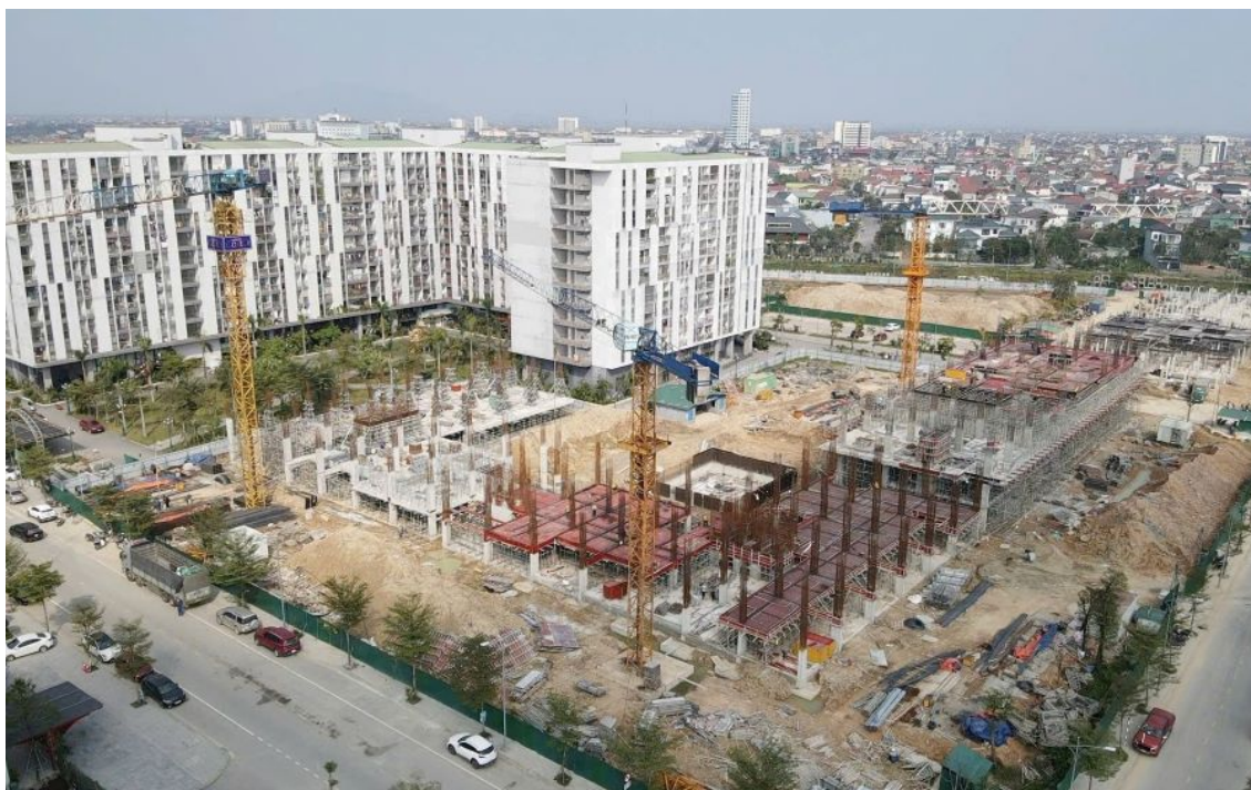
Đẩy nhanh tiến độ thi công dự án Nhà ở xã hội giai đoạn II tại phường Thành Sen
