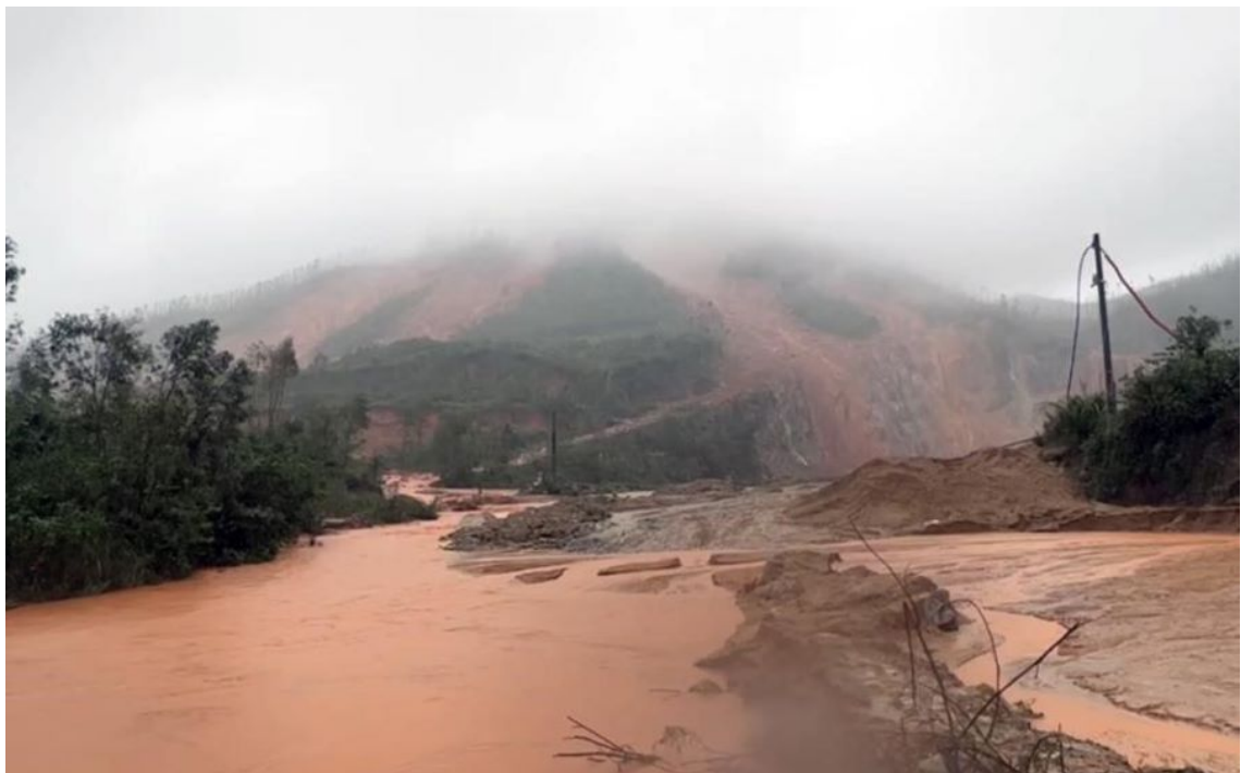
Khu vực bị sạt lở.
