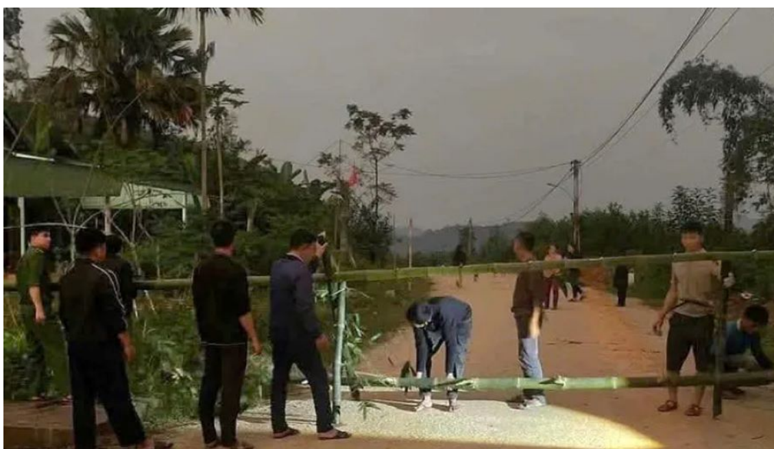
Chính quyền lập rào chắn, sơ tán 2 hộ dân đến nơi an toàn.
