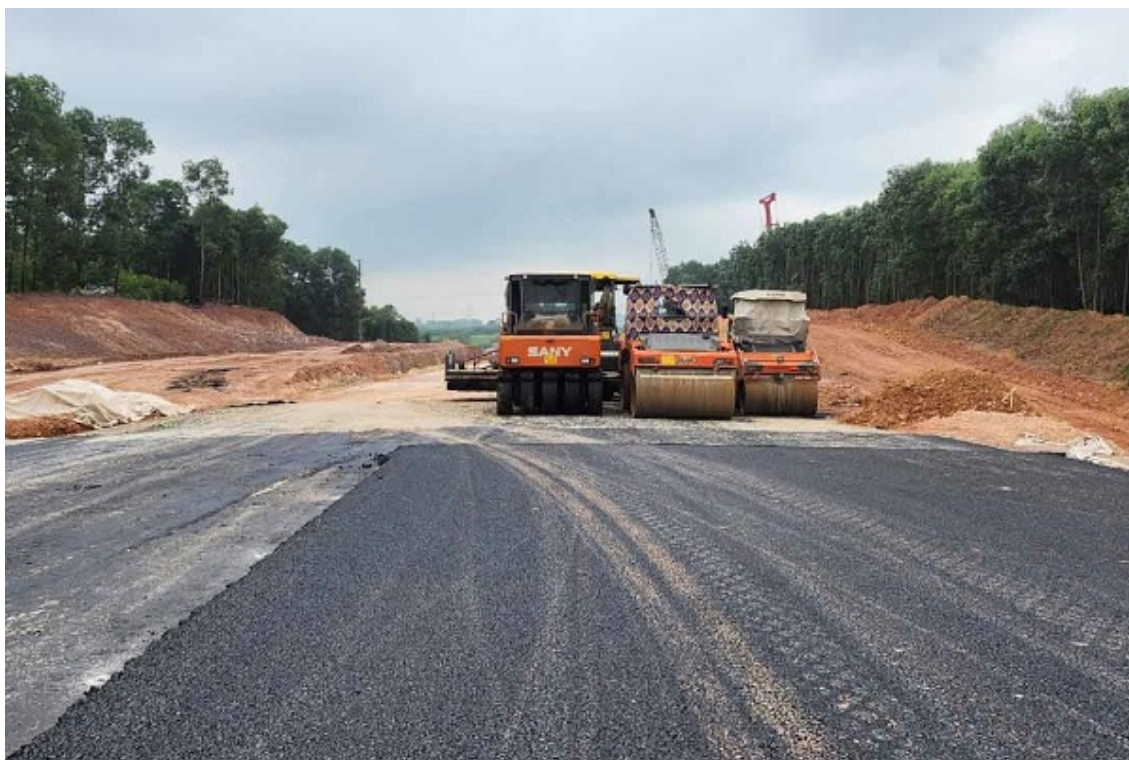
Dự án cao tốc Bắc - Nam đoạn Hàm Nghi - Vũng Áng đang được triển khai thi công đảm bảo tiến độ để ra.
