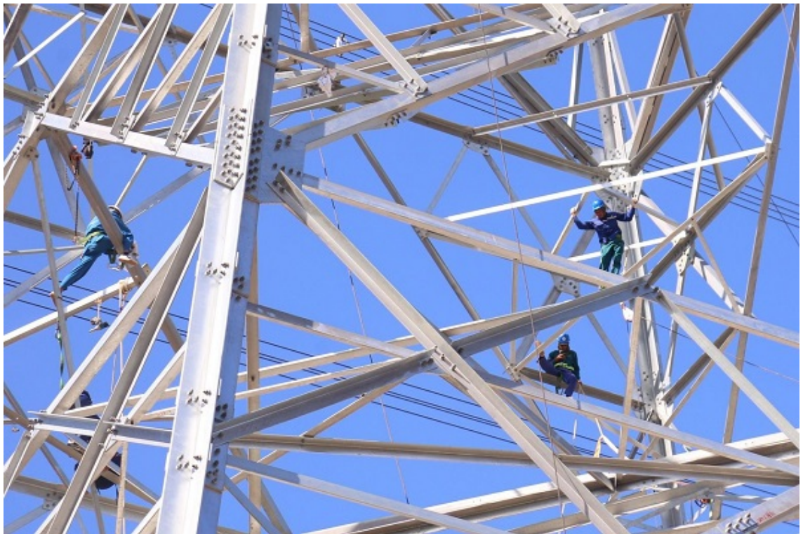
Công nhân thi công dự án đường dây 500 kV mạch 3 tại cột 09 ở xã Kỳ Nam, thị xã Kỳ Anh.
