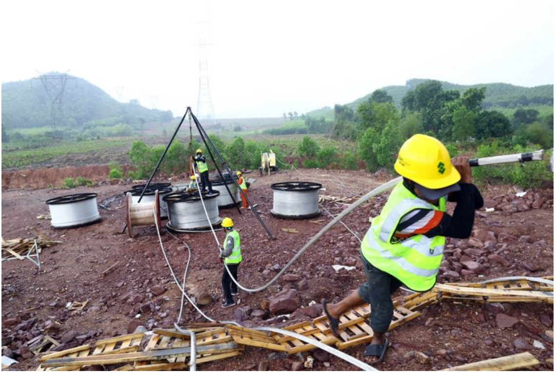
Thi công kéo dây đường dây 500kV mạch 3 đoạn qua huyện Cẩm Xuyên (Hà Tĩnh)
