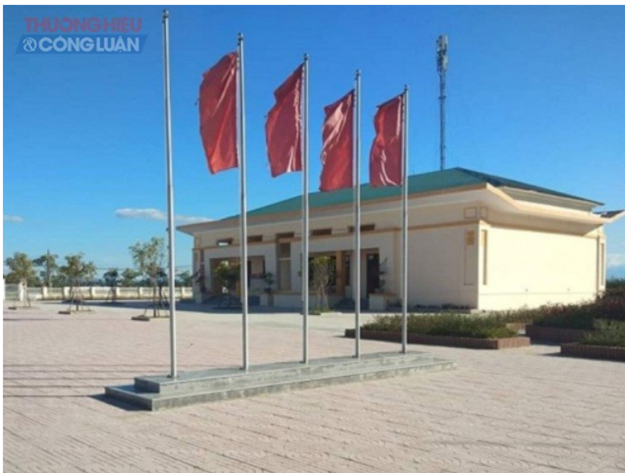
Dự án, công trình nhà hội trường xã Tân Lộc
