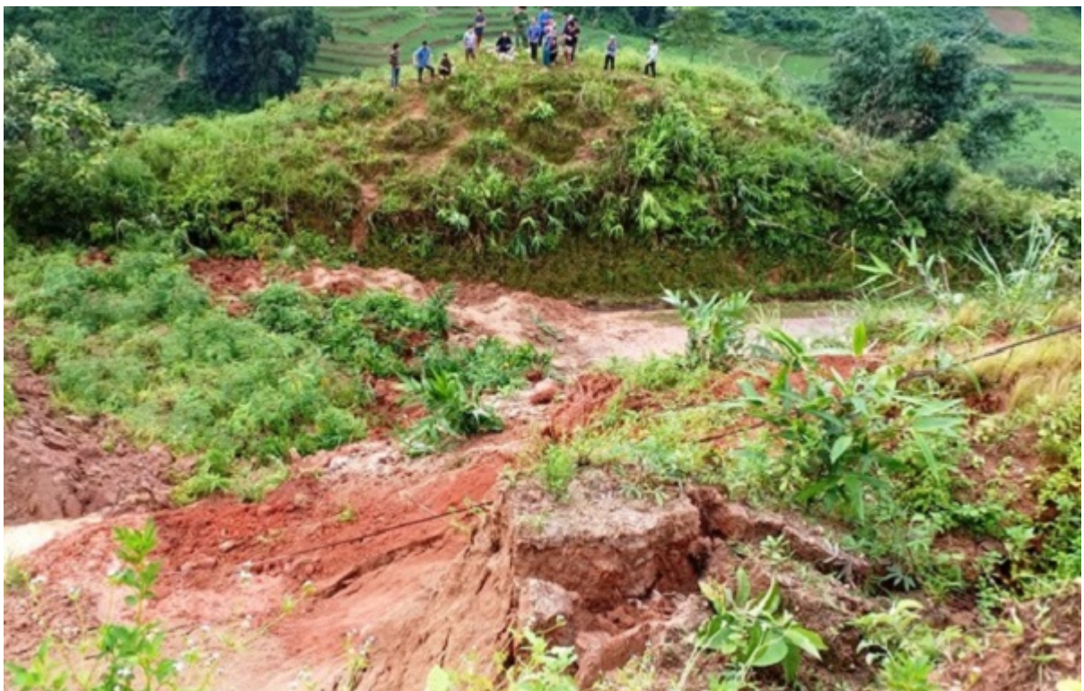
Hiện trường vụ sạt lở đất
