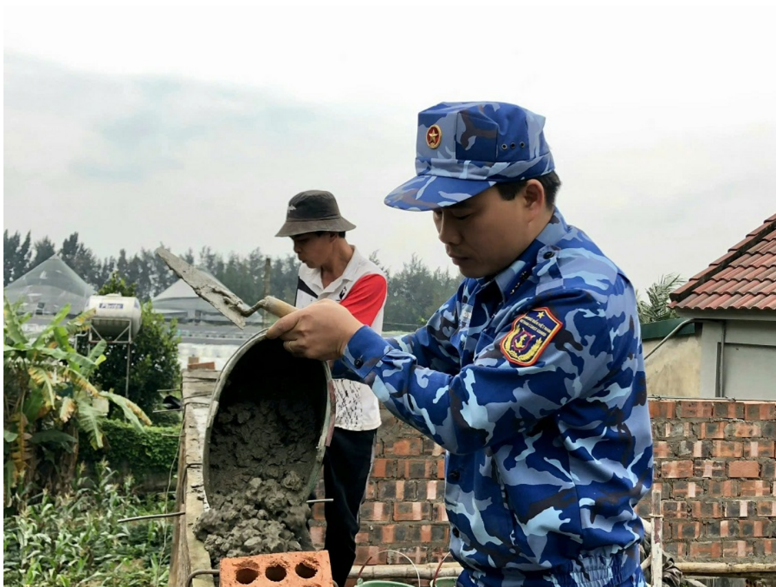
Giúp xây dựng căn nhà mới cho gia đình bà Tô Thị Chuyên (thôn Cường Thịnh, xã Cổ Đạm, Hà Tĩnh)
