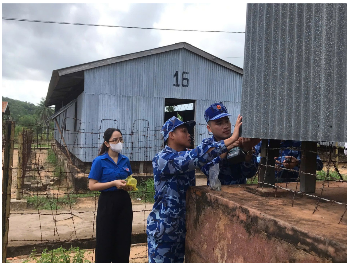
Cán bộ, chiến sĩ Hải đội 401 tổ chức củng cố, sửa chữa lại một số vị trí bị hư hỏng trong khuôn viên khu di tích nhà tù Phú Quốc.
