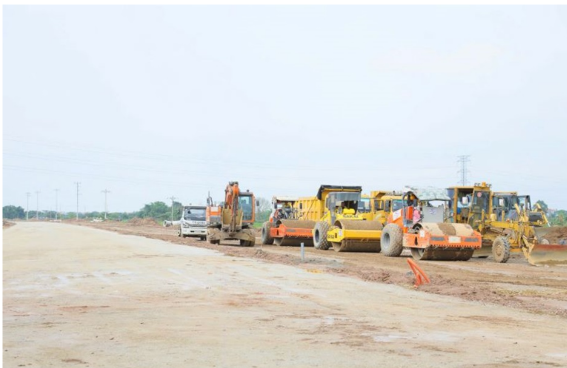
Dự án đầu tư xây dựng đường dẫn cầu Cậy mới và đường 33m kéo dài nối đường Vũ Công Đán.
