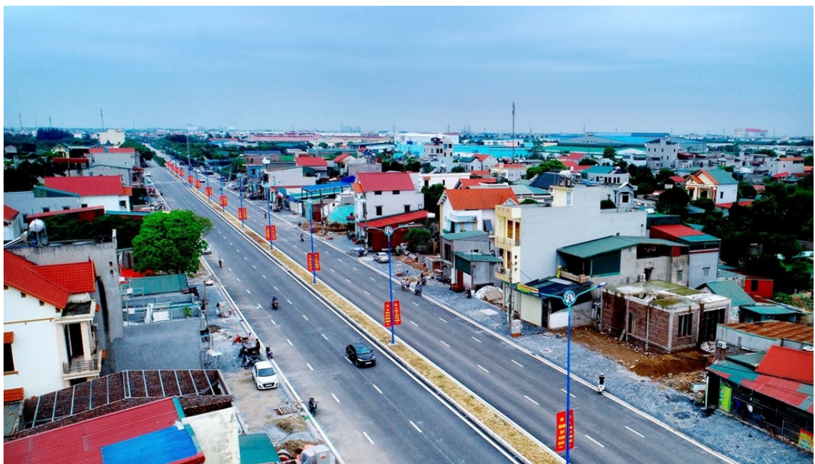
Dự án cải tạo mở rộng đường Vũ Công Đán kết nối TP Hải Dương với vùng huyện Cẩm Giàng
