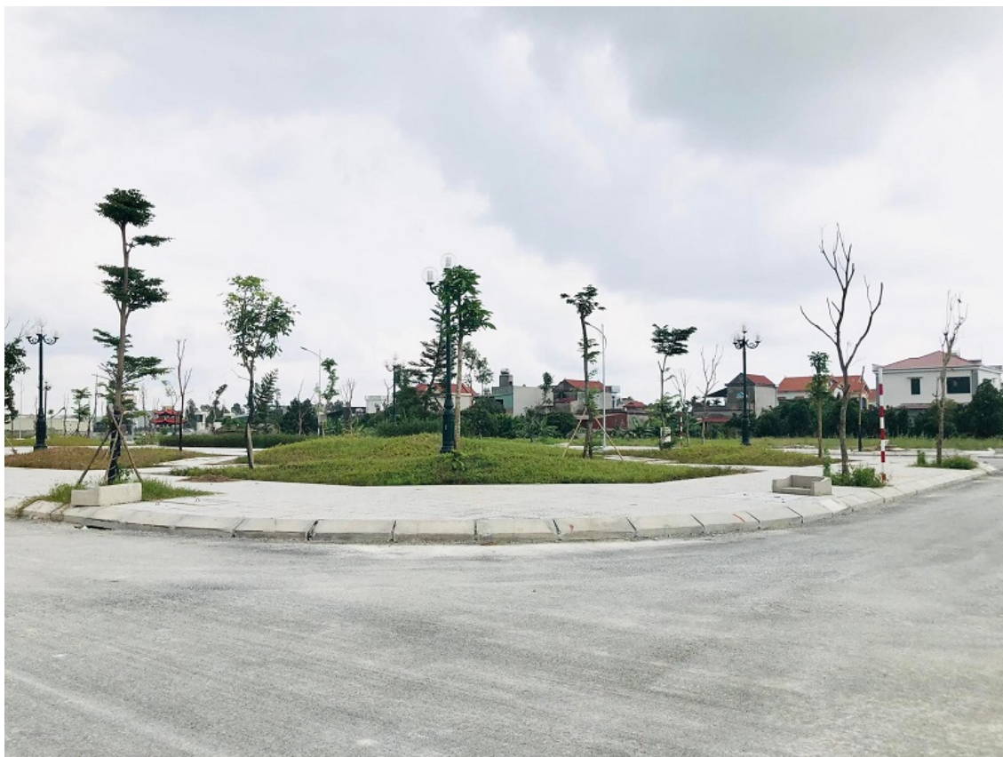
Khu vực vườn hoa, công viên đang được đi vào hoàn thiện.
