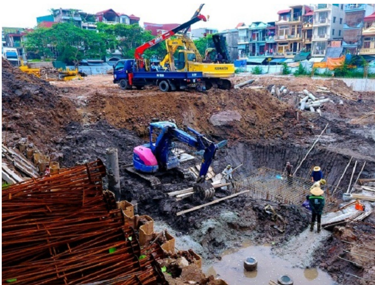
Thi công phần móng của dự án
