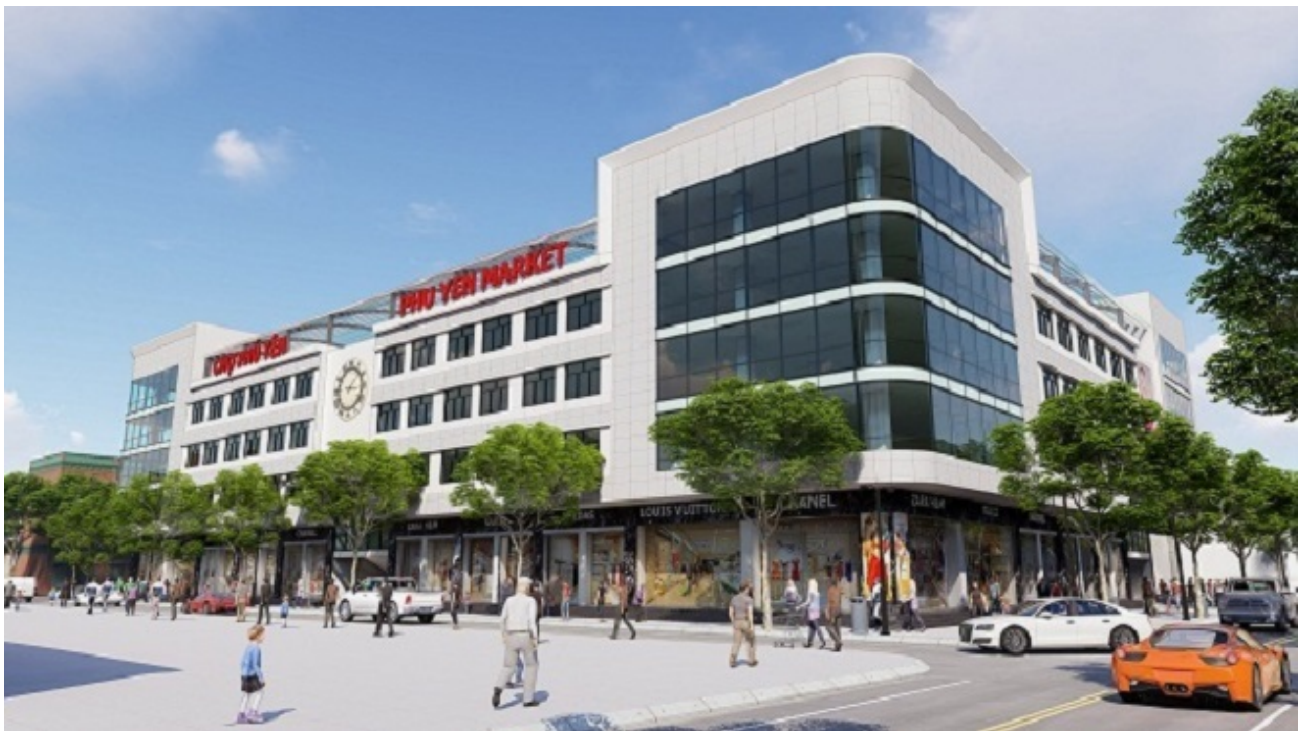
Chợ Phú Yên sau khi được xây dựng và hoàn thiện xong
