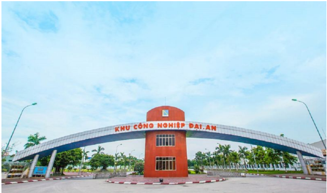
Khu công nghiệp Đại An mở rộng
