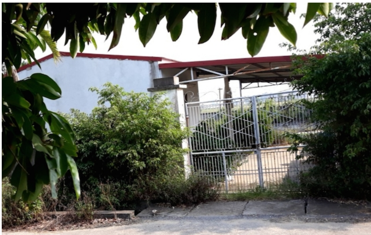
Nhà máy nước của ông Tiến phải đóng cửa, chờ phá sản từ tháng 6/2019 (Ảnh: Bùi Quốc Uy)
