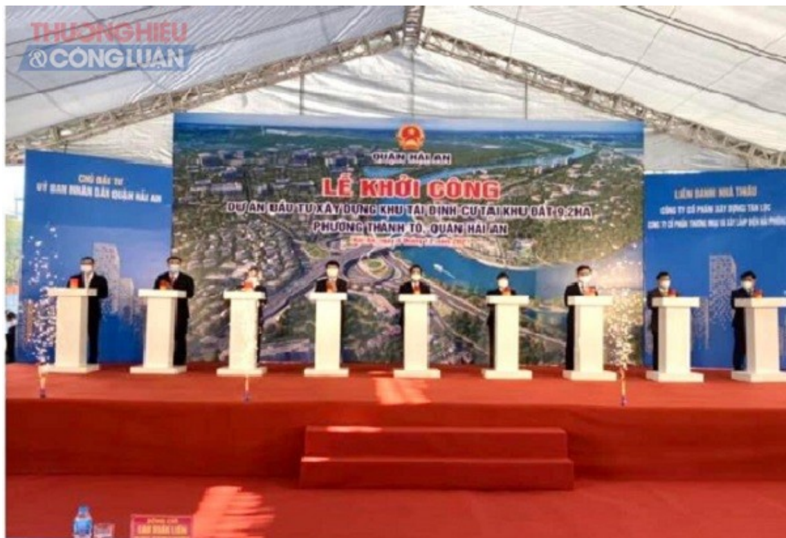
Khởi công xây dựng khu tái định cư tại khu đất 9,2 ha phường Thành Tô, quận Hải An.
