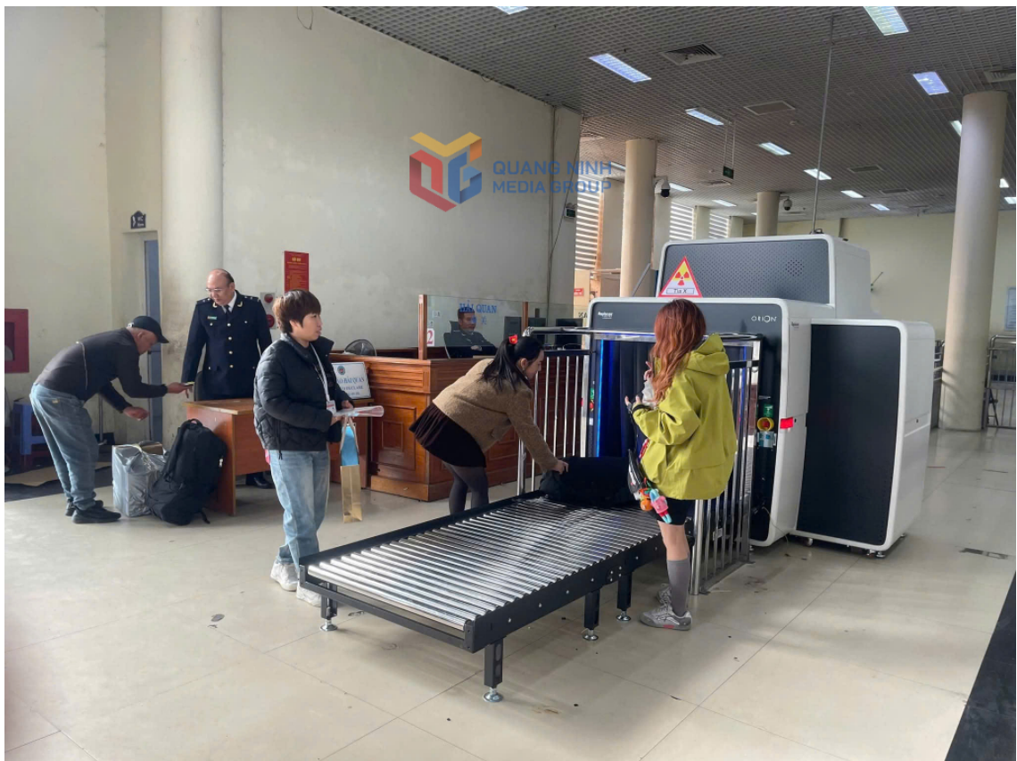
Máy soi hành lý được lắp đặt tại Cửa khẩu Quốc tế Móng Cái (Ảnh: QMG)
