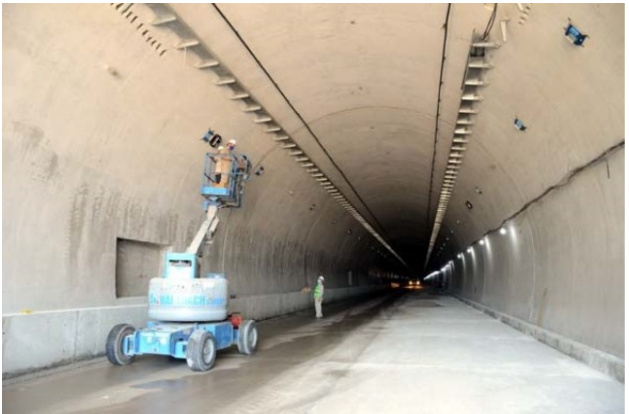
Thi công hệ thống điện chiếu sáng bên trong ống hầm.
