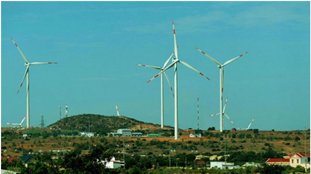
Một dự án điện gió tại huyện Tuy Phong, tỉnh Bình Thuận
