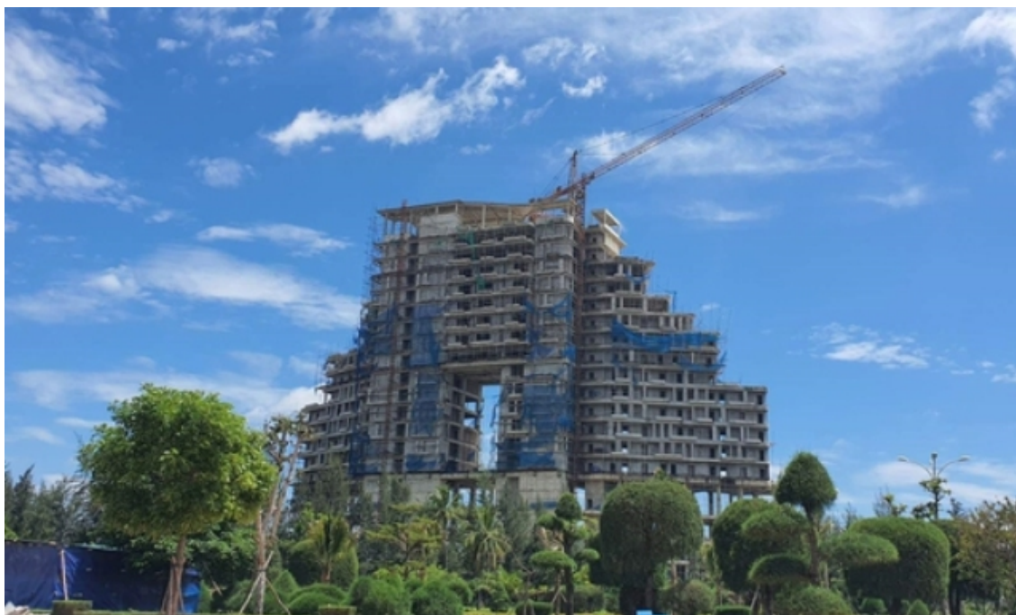
Dự án Khu du lịch sinh thái Sài Gòn - Bảo Ninh mới thi công phần thô tòa khách sạn
