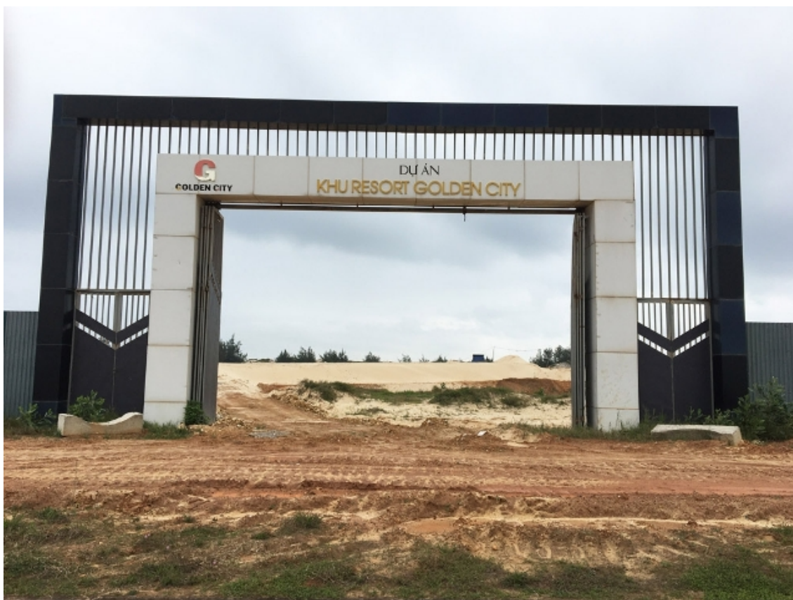
Dự án khu Resort Golden City mới san gạt mặt bằng, thi công một số hạng mục phụ trợ
