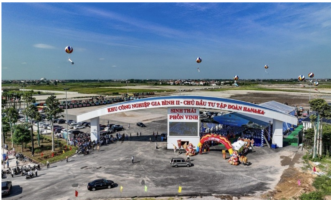
Ảnh 1: Khu công nghiệp Gia Bình II, Bắc Ninh do Tập đoàn Hanaka làm chủ đầu tư.
