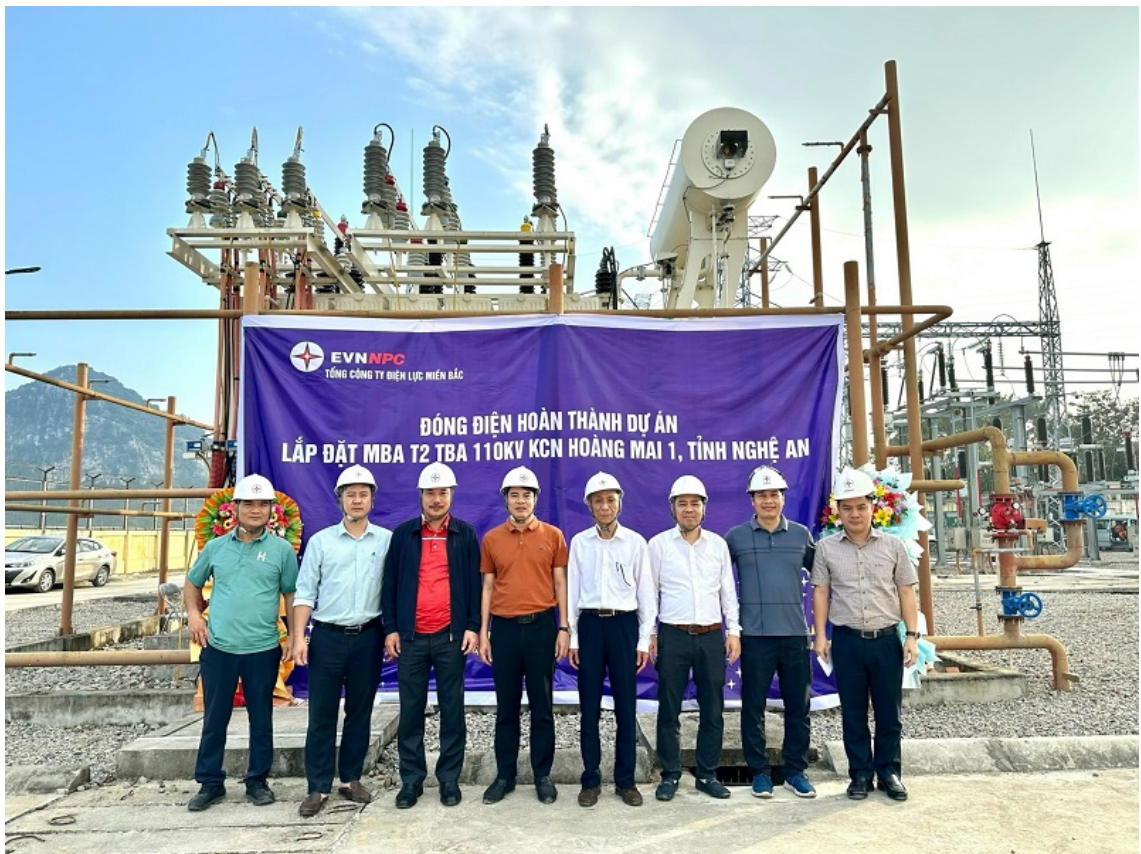
Hoàn thành đóng điện dự án Lắp đặt MBA T2 TBA 110kV KCN Hoàng Mai 1, tỉnh Nghệ An
