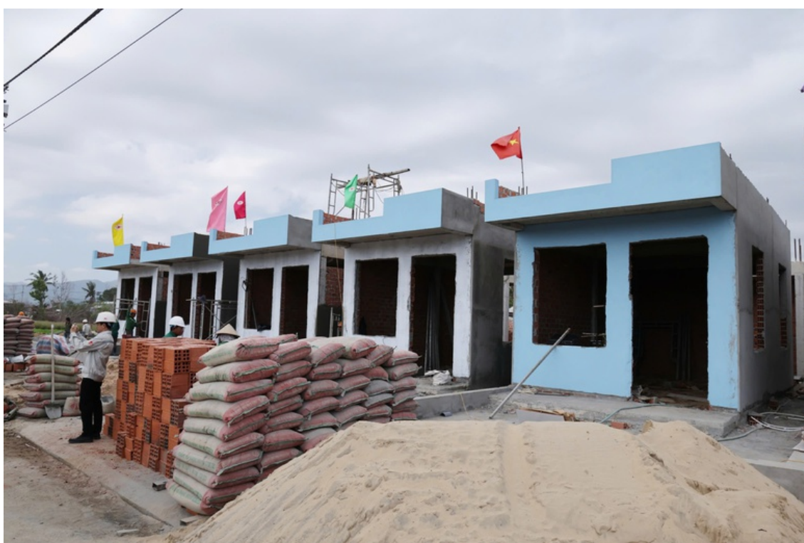
Triển khai "Chiến dịch Quang Trung", tỉnh Gia Lai đã ban hành Kế hoạch ra quân "thần tốc" hỗ trợ xây dựng, sửa chữa nhà ở cho người dân bị thiệt hại do bão số 13 và mưa lũ trên địa bàn tỉnh - Ảnh: VGP/Gia Huy
